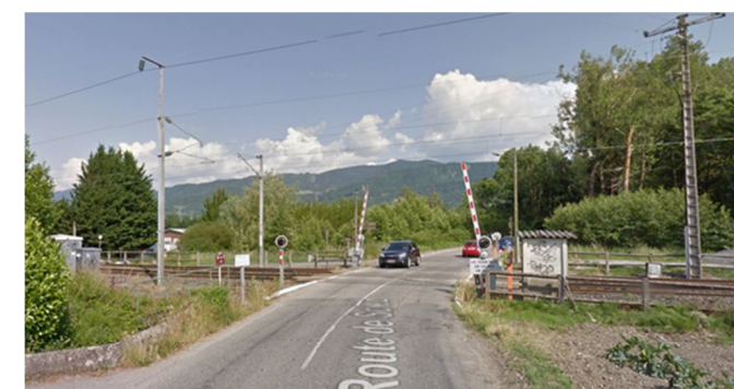
Photo 1 Passage à niveau n°65 (RD 25) – depuis la route de Sciez
