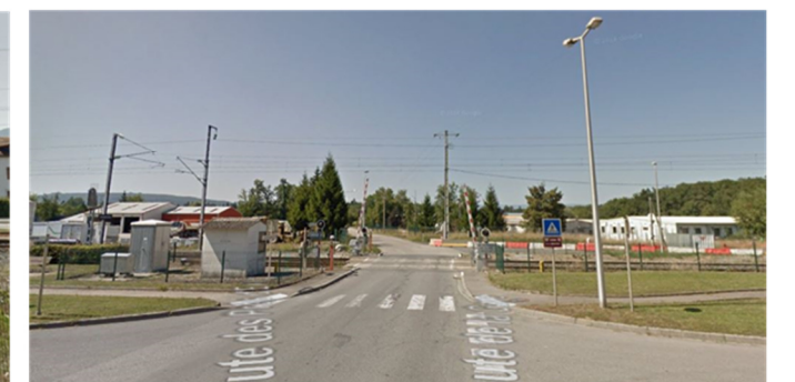
Photo 4 Passage à niveau n°66 (RD 135) – depuis la route de la Gare
