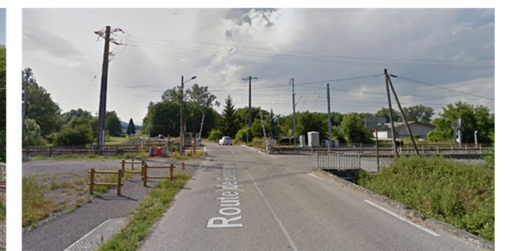
Photo 2 Passage à niveau n°65 (RD 25) – depuis la route de Brécors
