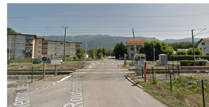
Photo 3 Passage à niveau n°66 (RD 135) – depuis la route des Grandes Teppes
